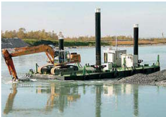
Der Geschiebehaushalt kann mit Entnahmen (Mündung Bodensee) oder Zugaben beeinflusst werden (Geschiebemanagement)
