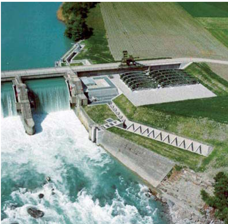
Die neue Fischaufstiegsanlage beim Kraftwerk Reichenau wird insbesondere von der Seeforelle rege benutzt. Im Jahre 2001 stiegen über 900 Fische vom Bodensee zu ihren ehemaligen Hauptlaichgebieten in Vorder- und Hinterrhein auf
