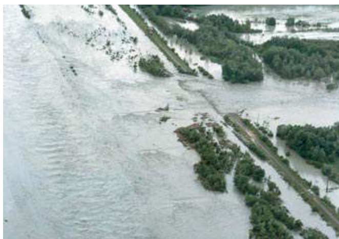
Dammbruch bei Fussach beim Hochwasser von 1987.
