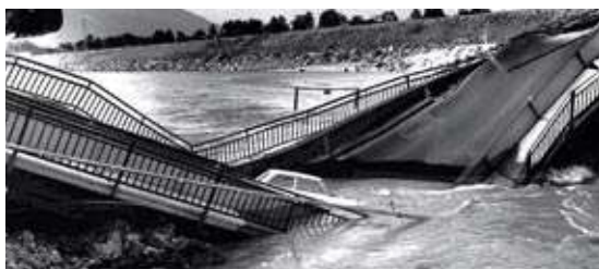
Wegen der Eintiefung des Flussbettes stürzte 1972 die Brücke Schaan-Buchs ein. Nach dem Brückeneinsturz wurden zahlreiche Kiesentnahmen eingestellt
