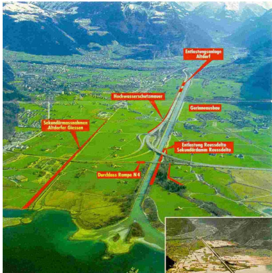
Bild 66: Das Hochwasser von 1987 führte im Urner Reusstal zu drei Dammbrüchen und grossen Überschwemmungen (kleines Bild). Die ausgeführten Hochwasserschutzmassnahmen umfassen neben dem Gerinnenausbau auch Massnahmen zur Beherrschung des Überlastfalls. Wird die Ausbauwassermenge überschritten, so fliesst Wasser auf die Autobahn. Eine Hochwasserschutzmauer und Sekundärmassnahmen beim Altdorfer Giessen verhindern, dass Siedlungsgebiete mit hohem Schadenpotential überflutet werden.
