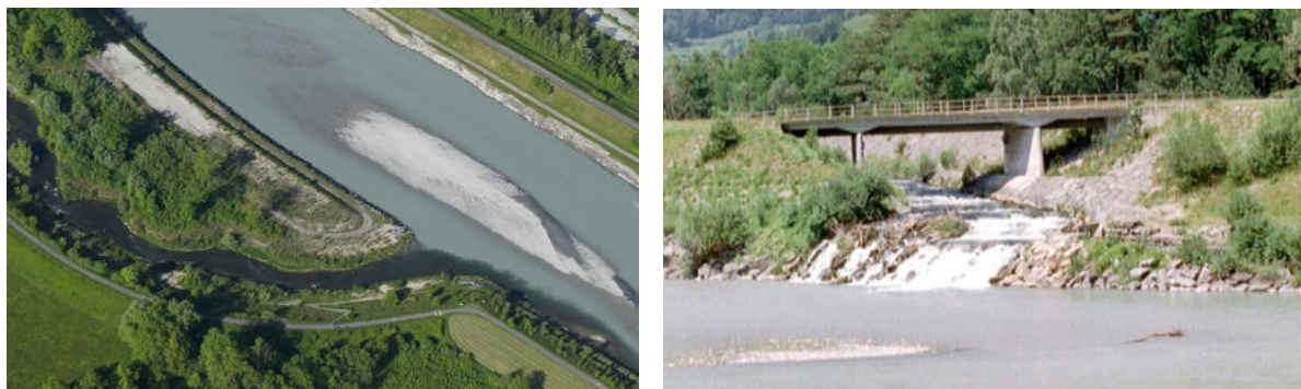
Bild 21: Niveaugleiche Mündung des Liechtensteiner Binnenkanals (links, Ausschnitt Aufnahme Dietmar Walser, walser-image.com) und Mündung des Saarkanals (rechts), welcher über eine raue Sohlrampe mit einer Gesamthöhe von etwa 3 m bestehend aus mehreren Sohlstufen mit je 50 cm Höhe in den Alpenrhein fließt. Die Sohlrampe weist eine für schwimmstarke Fische passierbare Fischeaufstiegshilfe auf, die allerdings vor den Sohlschwelen endet und periodisch von den alternierenden Kiesbänken verlegt wird.
