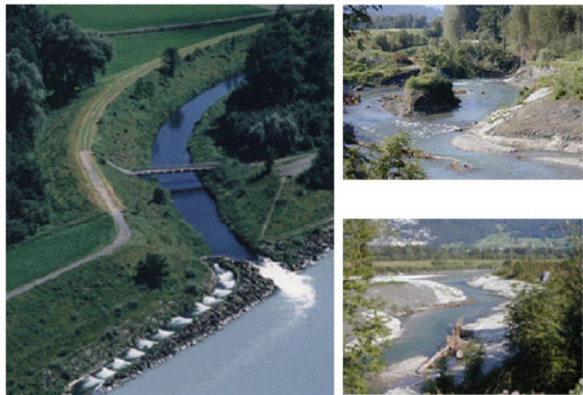
Bild 75: Mündung des Liechtensteiner Binnenkanals vor (links) und nach (rechts) der Umgestaltung
