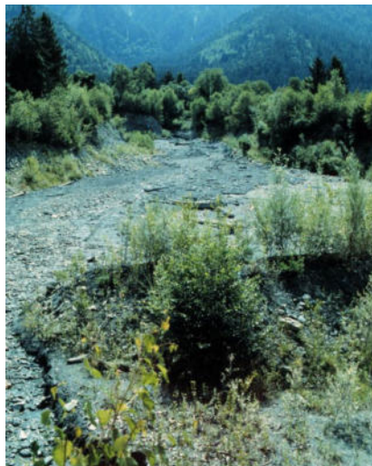
Bild 43: Ausschotterungsbecken der Valpargherarüfe bei Chur
