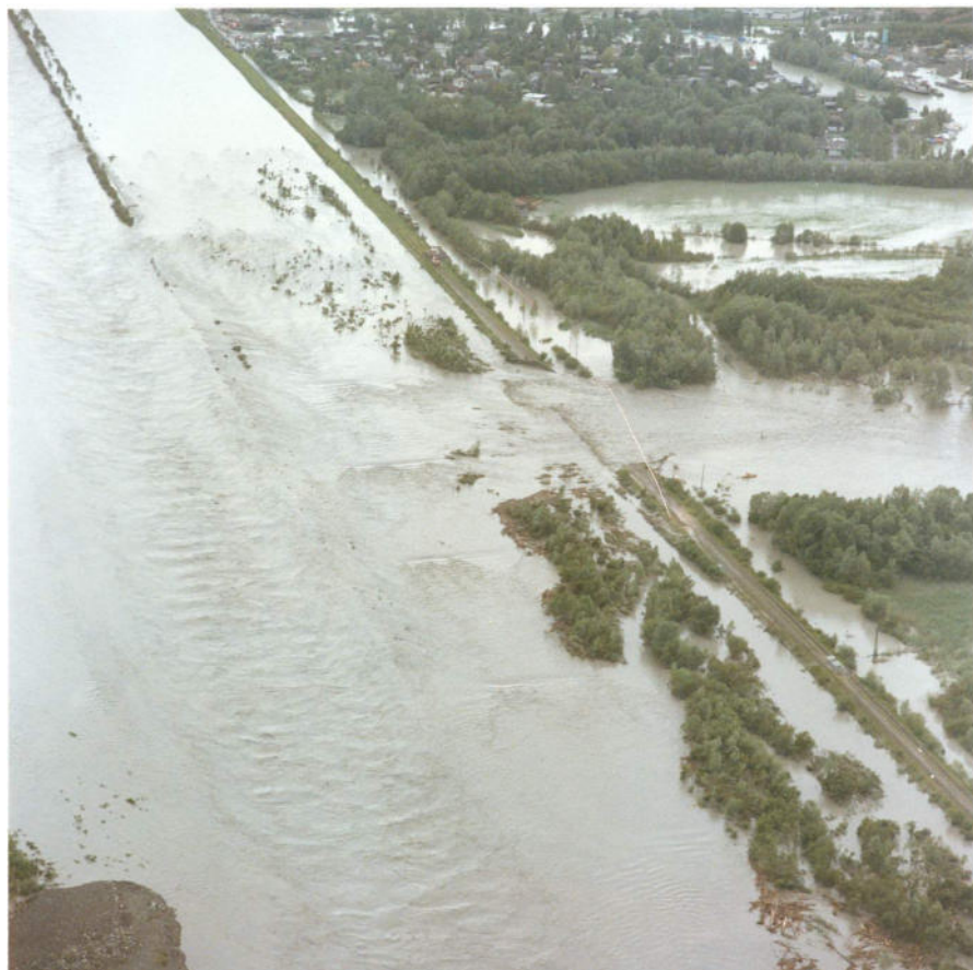
Bild 54: Dammbruch bei Fussach beim Hochwasser von 1987
