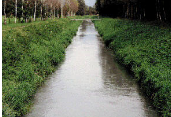
Bild 31: regulierter Ehbach im Vorarlberg
