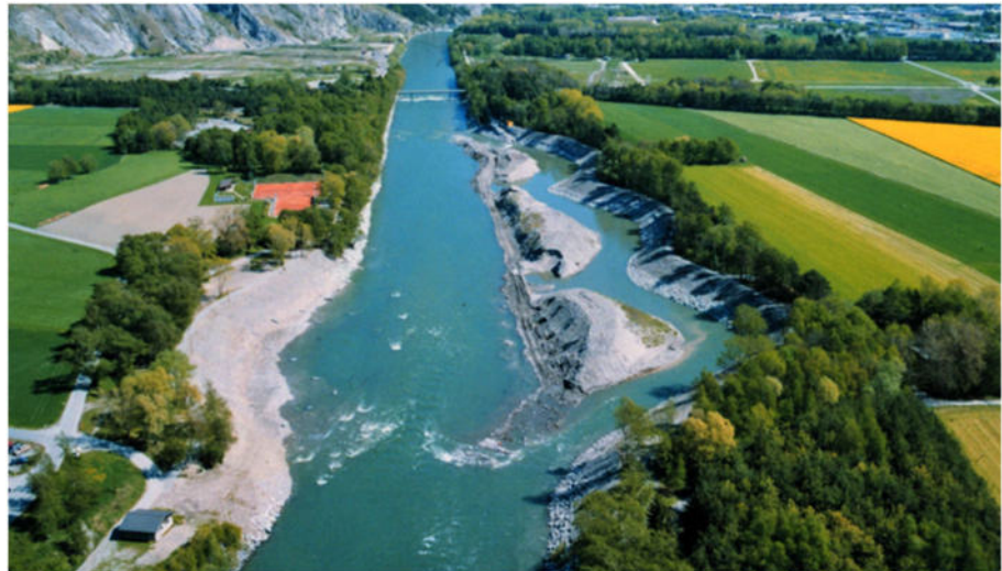
Bild 79: Uferschutzsanierungsmassnahmen als Chance für die kurzfristige Realisierung von Flussaufweitungen am Beispiel Chur/Felsberg, welche 1997 gebaut wurde.
